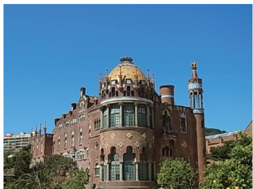
サン・パウ病院、各所で修復工事中
